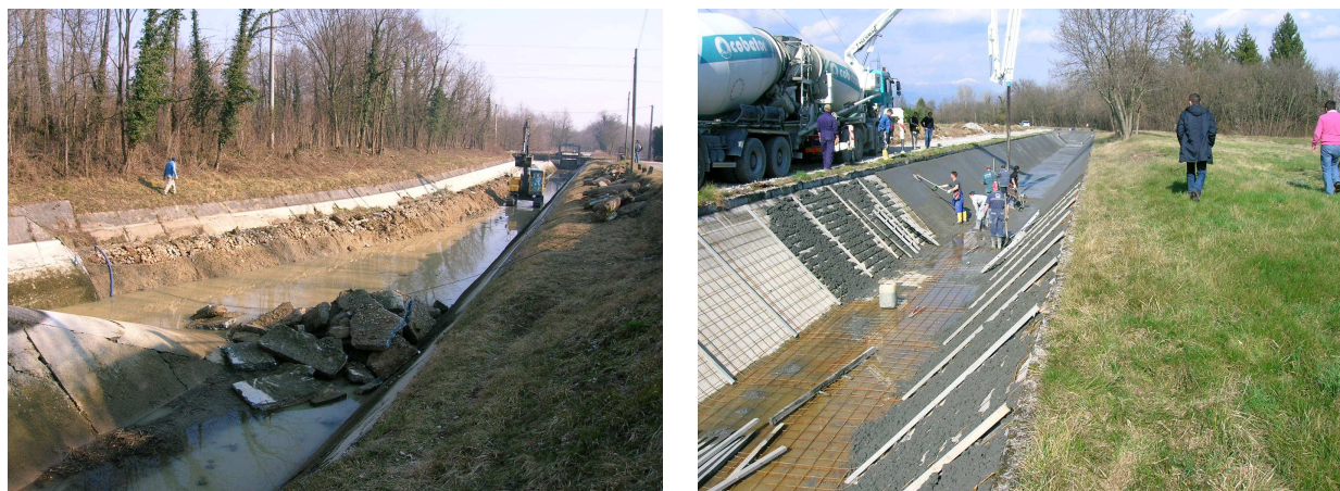
Figura 19 - Demolizione e rifacimento del rivestimento ammalorato su canale principale
