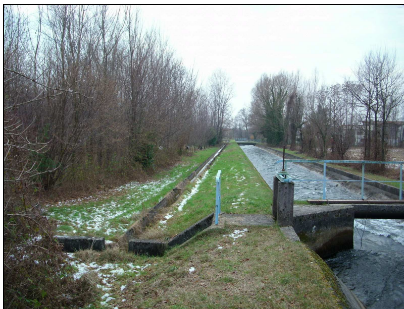
Figura 1 - Opera di presa su canale principale e canaletta distributrice prefabbricata
