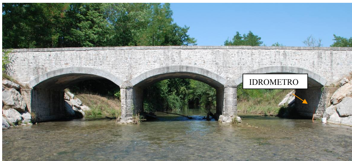
Figura 6.3.1: il ponte sul torrente Corno in località Barazzetto (Comune di Mereto di Tomba) e la posizione della strumentazione idrometrica
