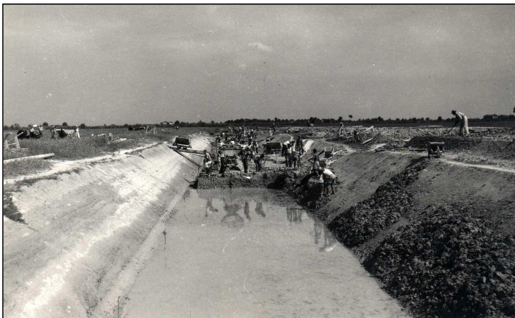
Esempi di opere di bonifica - Realizzazione di un canale di bonifica
