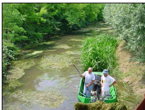
Attività di sfalcio svolta utilizzando lame sfalciate montate su barca e roncole a mano
