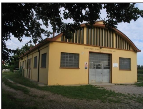
Capannone di Talmassons - ZSA
