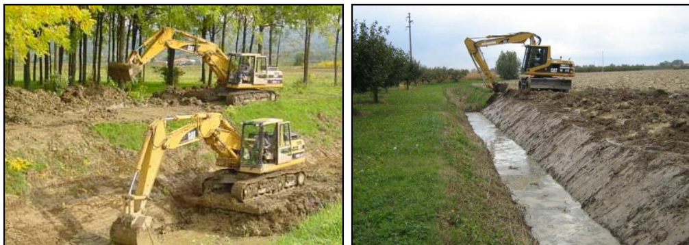
Espurghi di canali di scolo con escavatori
