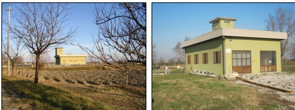
Impianto Boscat pluvirriguo (Grado)
