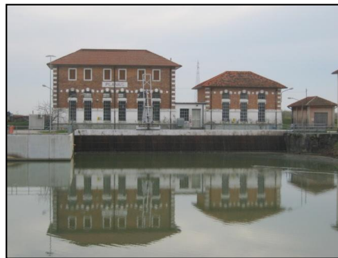
Idrovora Planais Vecchia (San Giorgio di Nogaro)
