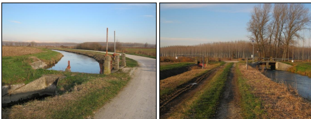
Derivazioni Brodiz-Miliana: I° presa, a sinistra, e II° presa, a destra (Rivignano)
