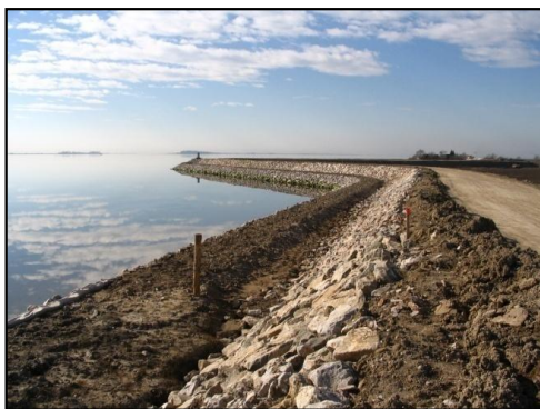
Argine a laguna in costruzione (Aquileia)
