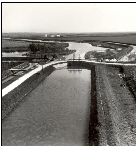
Esempi di opere di bonifica - Nodo idraulico sul Canale Tiel
