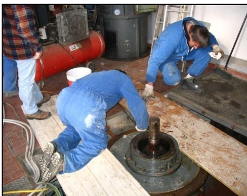
Manutenzione di motori e di pompe (lubrificazione ed ingrassaggio)
