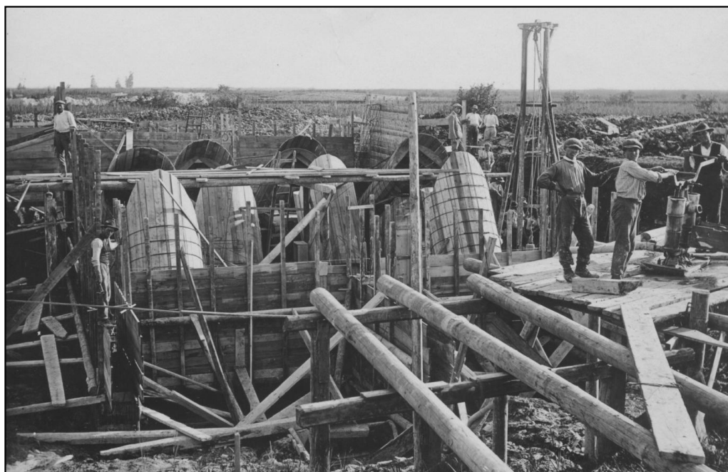
Esempi di opere di bonifica - Costruzione dell'idrovora Ca' Anfora
