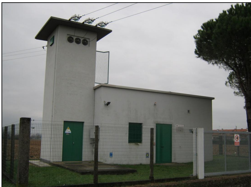
Pozzo 342 - impianto pluvirriguo Passariano
