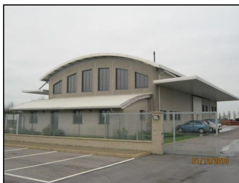
Capannone di Aquileia
