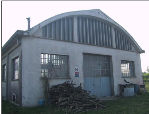
Capannone di Morsano (Castions di Strada) - ZSA
