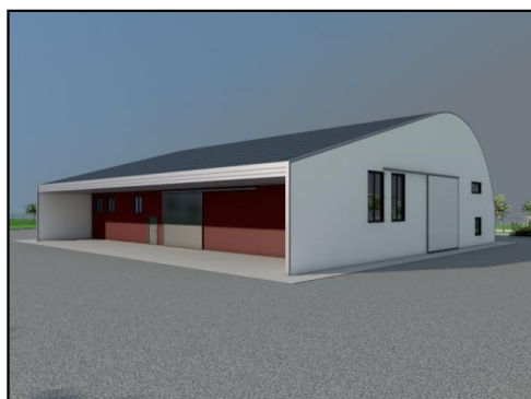
Capannone di Latisana (in costruzione)
