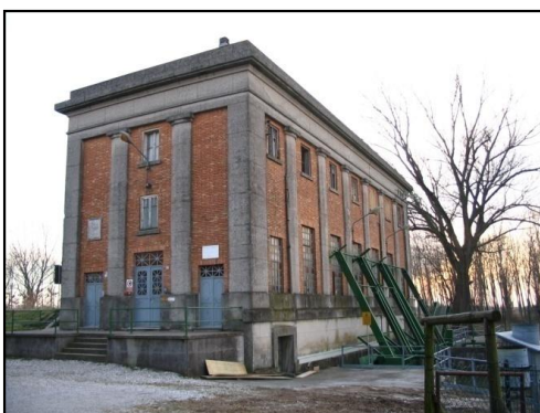
Idrovora Ca' Anfora Nuova (Terzo d'Aquileia)
