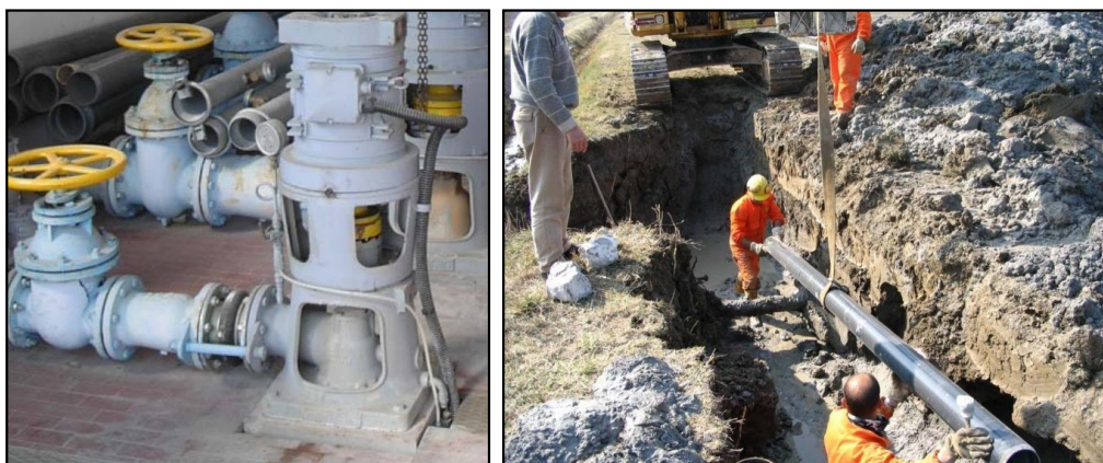
Pompe e tubazioni di mandata di una stazione di pompaggio e la posa una condotta irrigua in PVC
