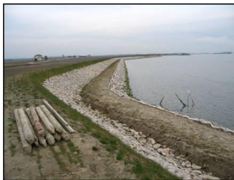
Argine a laguna a lavori ultimati (Latisana)
