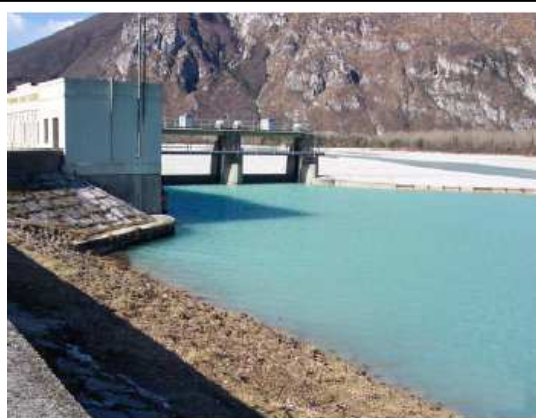
Figura 105 - Consorzio Ledra Tagliamento: opera di presa di Ospedaletto in comune di Gemona del Friuli
