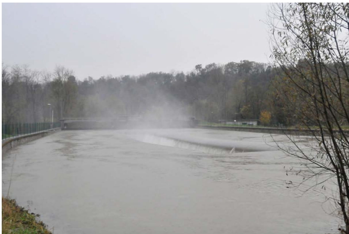
Figura 21 - Scolmatore di San Mauro sul fiume Corno in funzione
