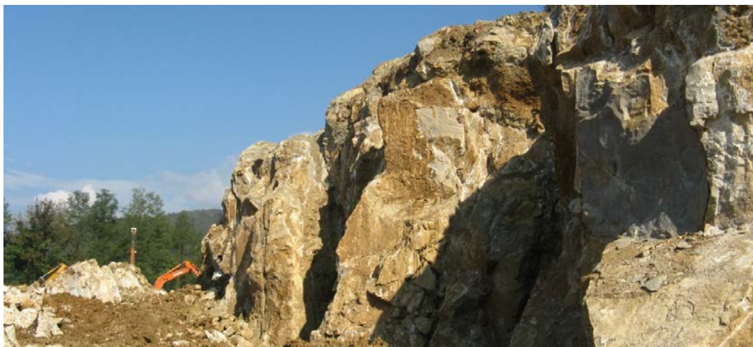
Lavori di scoperta del giacimento di Pietra Piasentina (Cava Clastra, UD)
