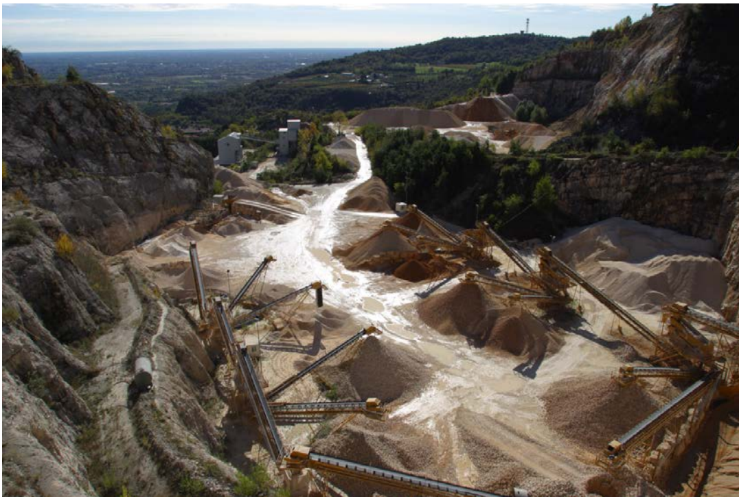
Impianto di produzione degli aggregati di una cava di monte; sullo sfondo l'impianto dei granulati (Cava di Sarone, PN)
