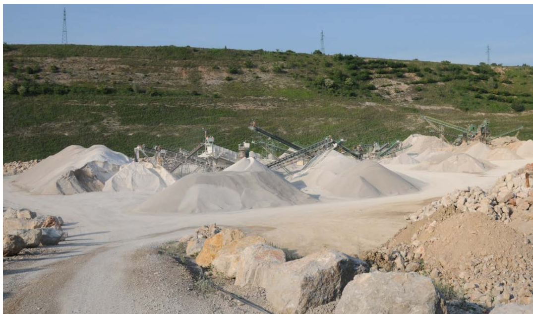
Impianto di produzione degli aggregati di una cava pedemontana (Cava Monte Sei Busi, GO)
