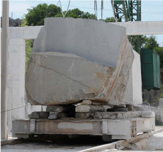
Blocco di Repen Classico Zolla: durante la riquadratura con taglio al filo statico ed a termine operazione (Cava Babce Nord, TS)
