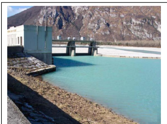
Figura 80 - Consorzio Ledra Tagliamento: opera di presa di Ospedaletto in comune di Gemona del Friuli
