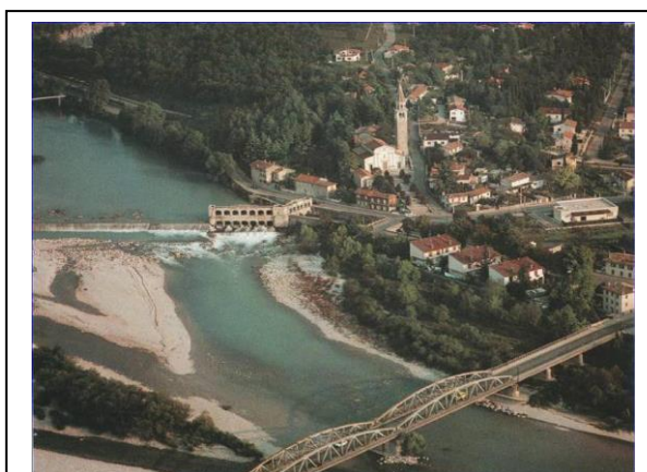
Figura 85 - Derivazione a usi irrigui e idroelettrici in comune di Sagrado
