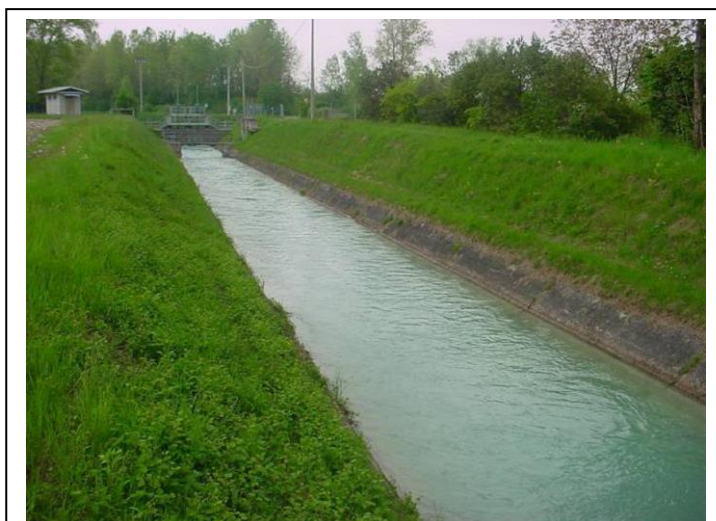
Figura 75 - Comprensorio di bonifica Cellina Meduna: canale principale di Villa Rinaldi che alimenta i comizi irrigui a scorrimento nella zona nord di Pordenone compresa tra l'abitato di Cordenons e Fontanafredda
