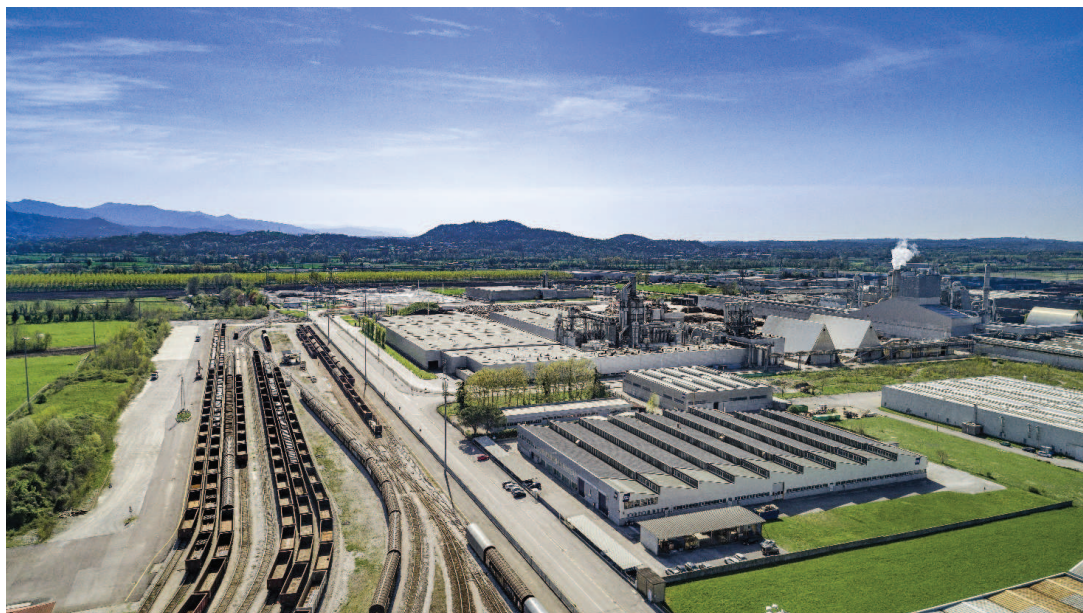
Scalo ferroviario Osoppo
