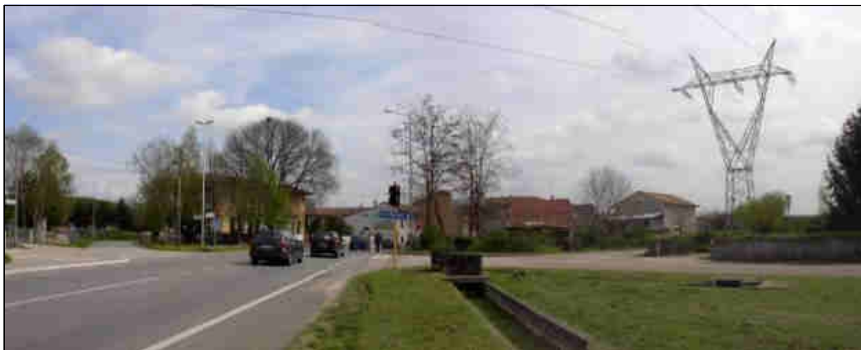
Foto 1: Abitato di Basagliapenta: in un contesto di edifici bassi, l'interferenza del viadotto sarà elevata.
