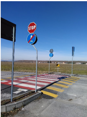
Esempi di attraversamento ciclopedonale con asfalto colorato e rialzo, solo pedonale con rialzo, solo pedonale con asfalto colorato.
