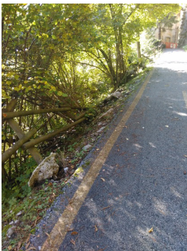
Esempi di protezione laterale danneggiata, pericolosa.
