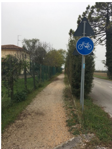
Esempio di elementi delimitatori che non sono protezioni laterali: siepi, recinzioni, paletti, guard-rail stradali.
