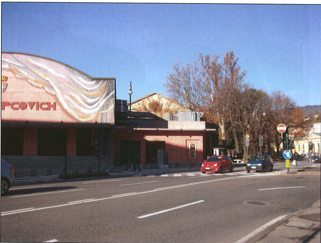
Vista dall'imbocco di Corso Cavour, occlusa dalla Sala Tripovich
