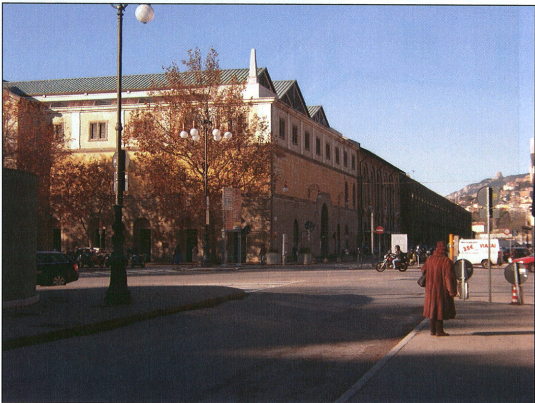
Lato a fianco della Stazione - Sono evidenti le superfetazioni del 1994
