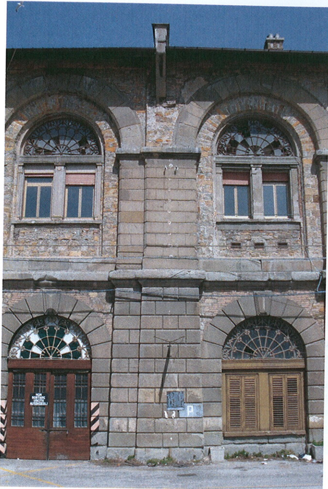
Foto 15: Particolare facciata verso cortile Ovest
