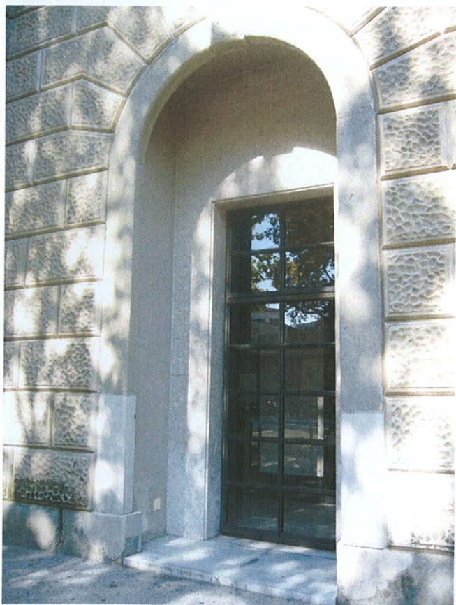
Foto 14: Testata, facciata Ovest – Nicchia e porta scorrevole in ferro, al piano terra dell'Autostazione
