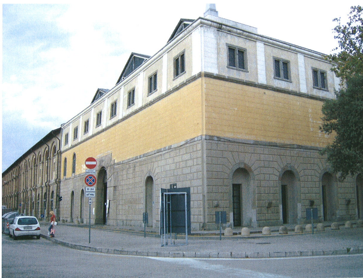
Foto 10: Testata dei Silos – copertura a triplice falda, fine corsa ascensori come basamenti degli obelischi d'angolo
