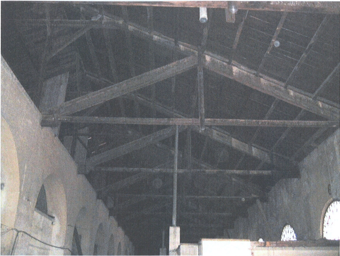
Foto 18: Struttura in legno della copertura ala ovest
