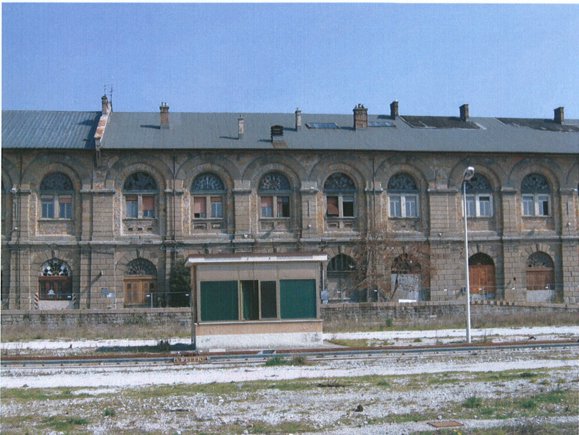
Foto 19: Ala ovest dal cortile ovest : muro tagliafuoco, comignoli e lucernai in copertura
