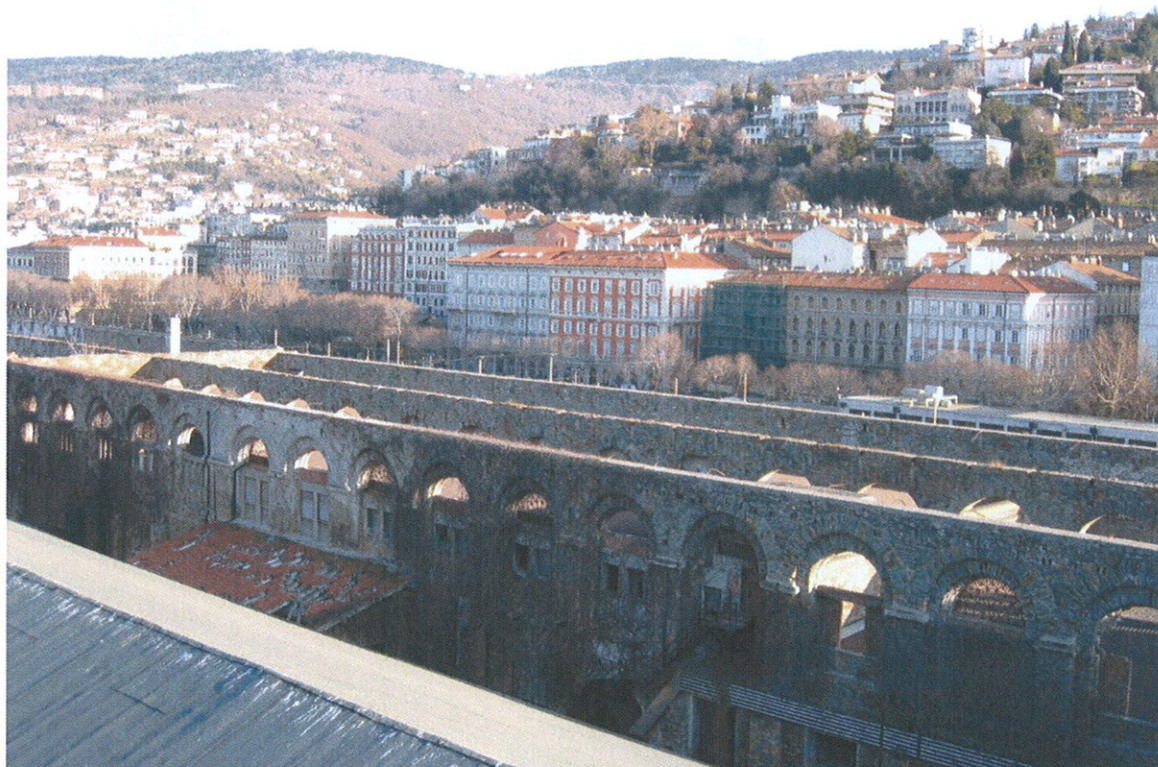
Foto 9: Cortile e ala est visti dalla copertura ala ovest – sullo sfondo la collina di Scorcola
