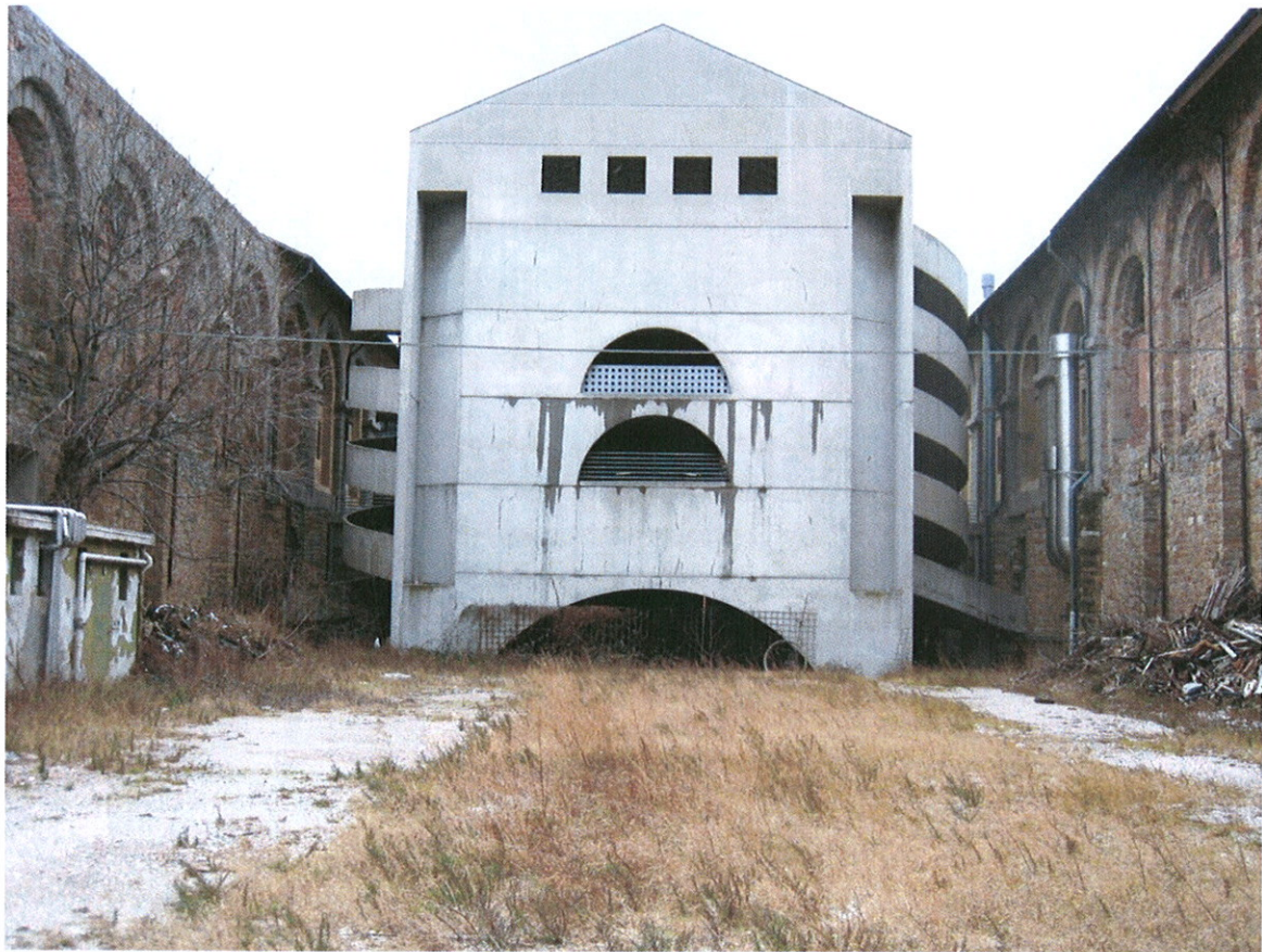
Foto 11: Vista verso la testata del cortile interno o "Cava", con la facciata del corpo rampe autosilo
