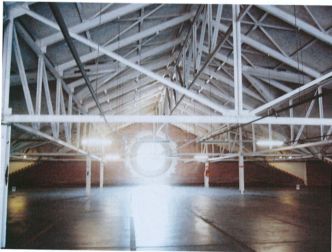
Foto 17: Piano quarto della Testata - Copertura a triplice falda dell'autosilo con struttura in ferro
