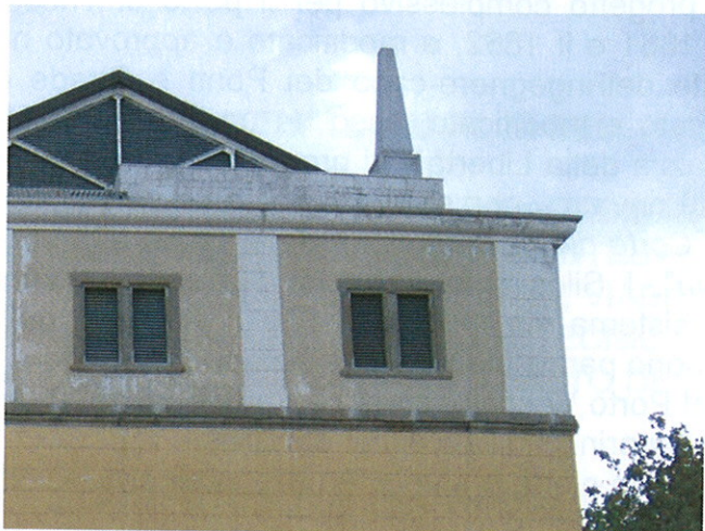
Particolare d'angolo della testata ristrutturata
