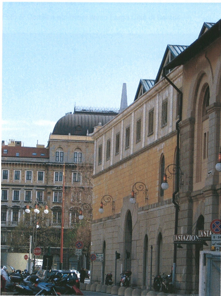
Foto 2: Testata Silos su via Gioia – oggi, dopo l'attuazione del progetto Semerani-Tamaro
