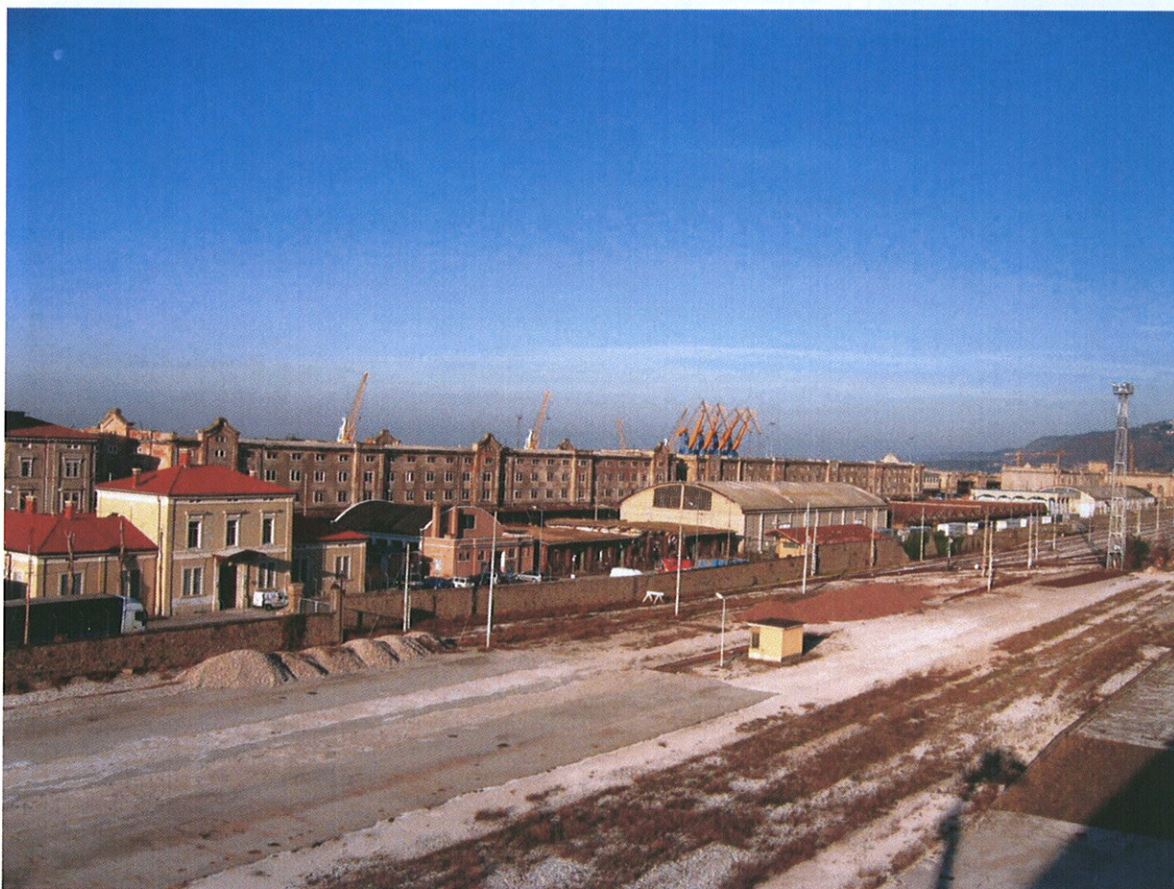
Foto 6: Cortile verso Porto Vecchio dalla copertura dell'ala ovest
