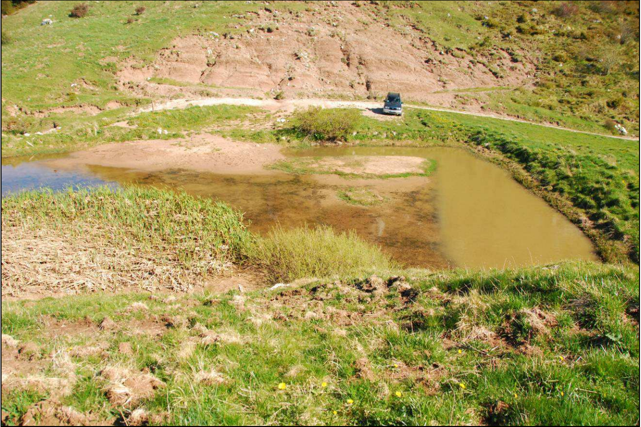
Pozza di malga Ungarina. Come si può vedere a monte vi è la presenza di un corpo franoso che determina il progressivo interrimento della pozza
