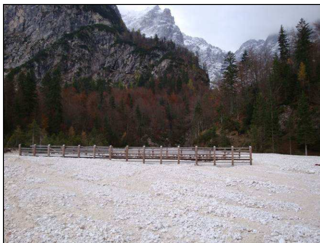
Figura 30 - Sovralluvionamento in Val Saisera con sepellimento del ponte a servizio della pista da sci.
