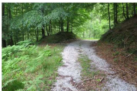
Foto n. 1: sezione 93 con collegamento alla strada forestale esistente.
