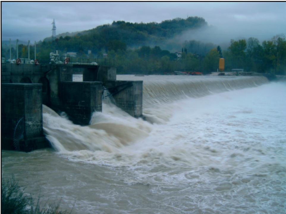
Figura 25: Piena del torrente Torre in corrispondenza della traversa a servizio della presa irrigua di Zompitta
