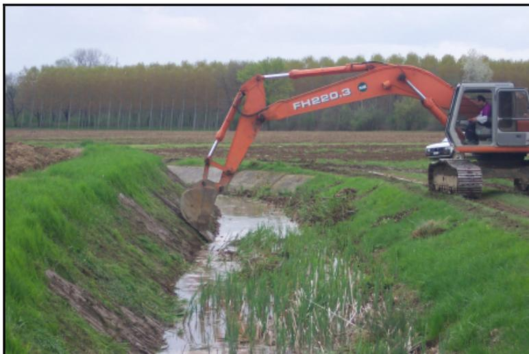
Figura 17: Lavori di espurgo e risagomatura di un canale di scolo
