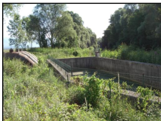
Figura 20: Bacino e sifoni di scarico dell'impianto idrovo di San Daniele (loc. Paludo)
