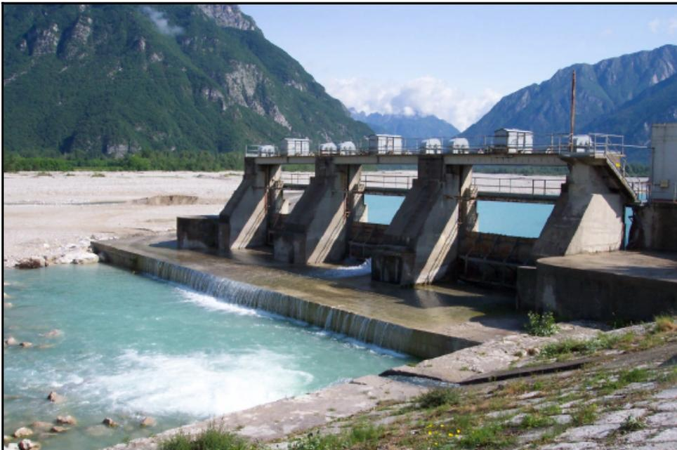
Figura 23. Particolare della traversa sul fiume Tagliamento presso l'opera di presa di Ospedaletto,
