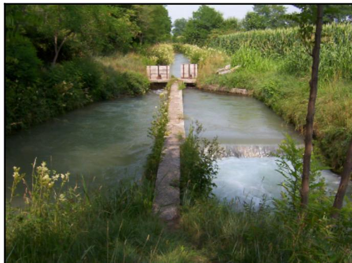
Figura 35. Manufatto di regolazione per la distribuzione dell'acqua nelle aree con irrigazione a scorrimento
