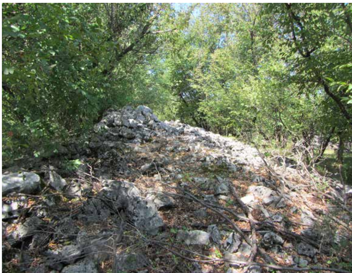
1. Le imponenti macerie del circuito difensivo del castelliere (lato nord).
