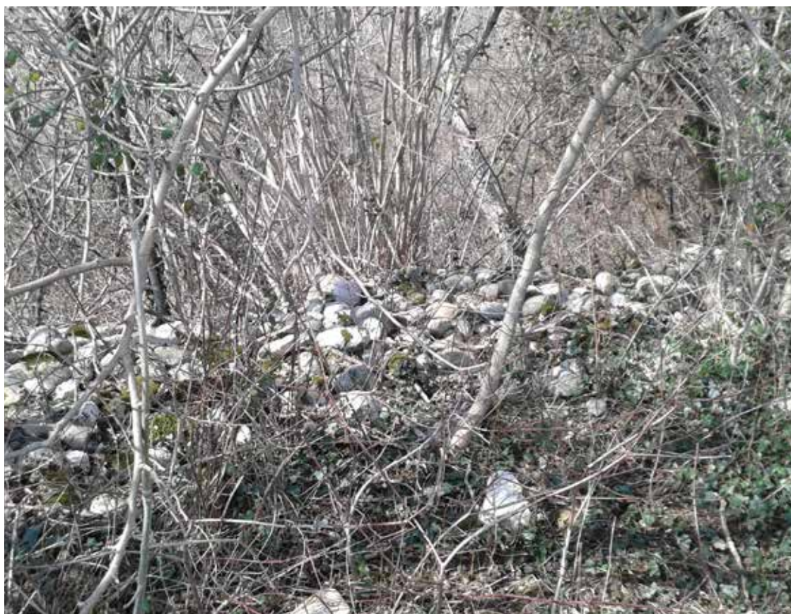
7. Accumulo di ciottoli esito della demolizione del terrapieno del castelliere.
