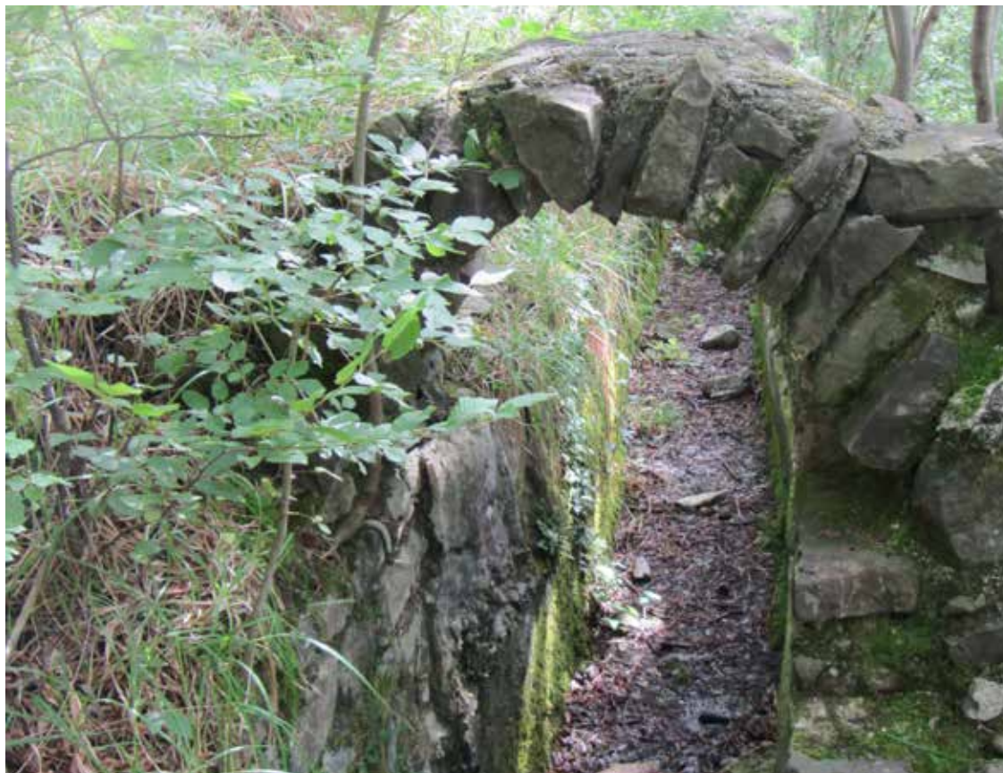
3. L'acquedotto romano in un tratto conservato con la volta a botte.
