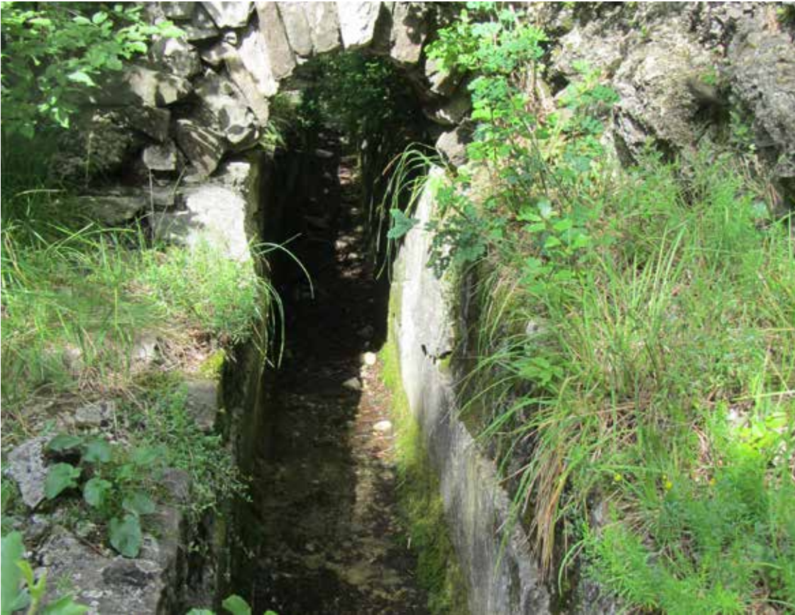
5. L'infrastruttura idrica di età romana si presenta oggi ricoperta da fitta vegetazione spontanea.
