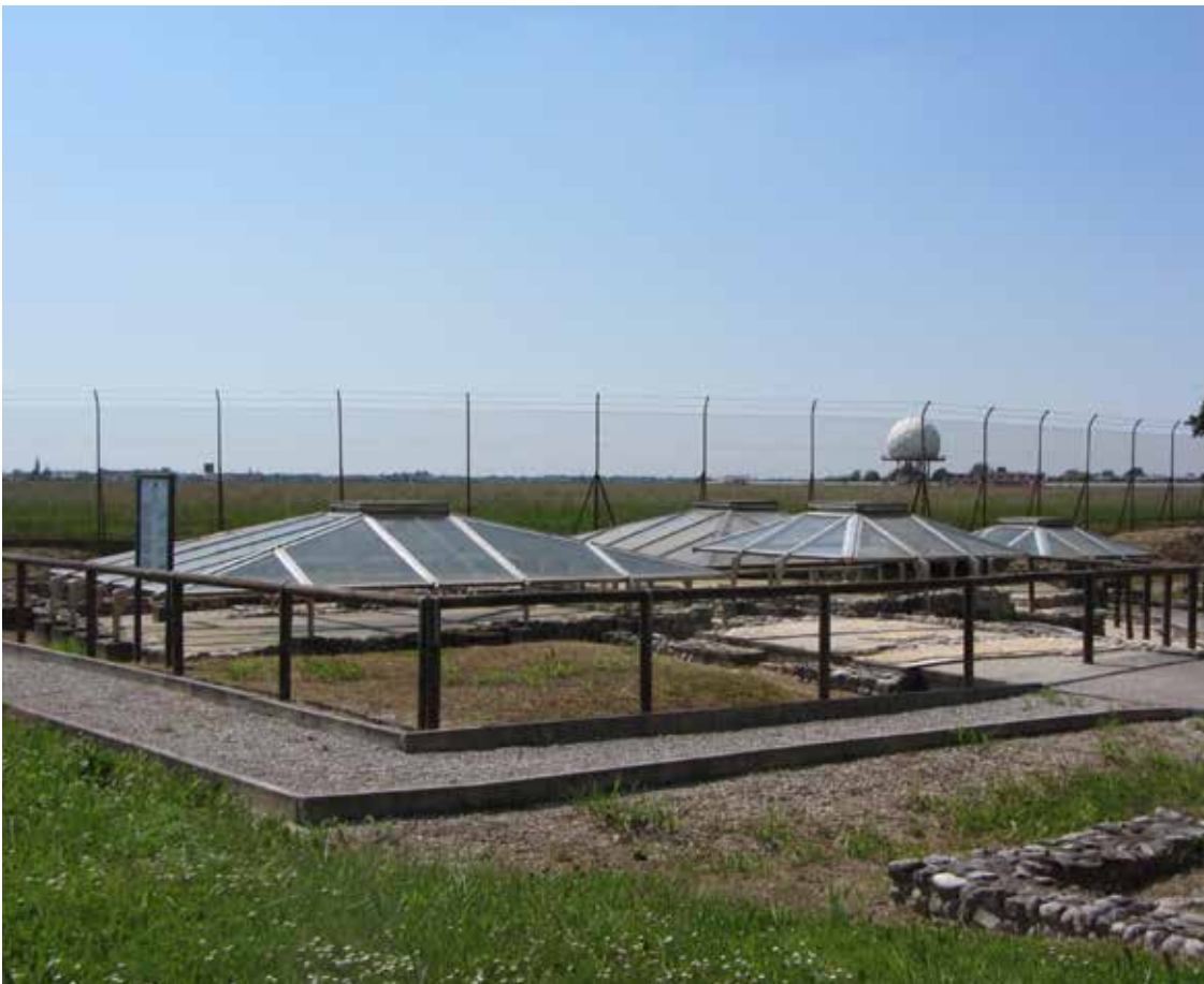
6. L'area archeologica come si presenta oggi con le coperture in corrispondenza dei pavimenti musivi.
