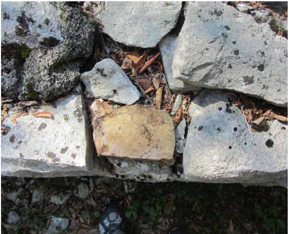
8. Particolare di una delle murature con l'inserimento di un laterizio.
