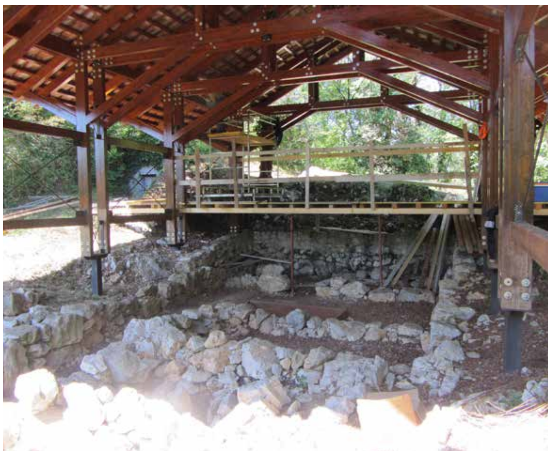
9. Una delle coperture attualmente in fase di ripristino da parte del Comune.
