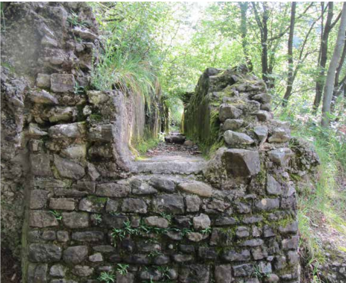
6. Particolare della struttura del canale.
