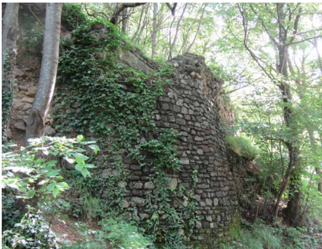
10. L'imponente sostruzione dell'acquedotto romano di Bagnoli della Rosandra.
