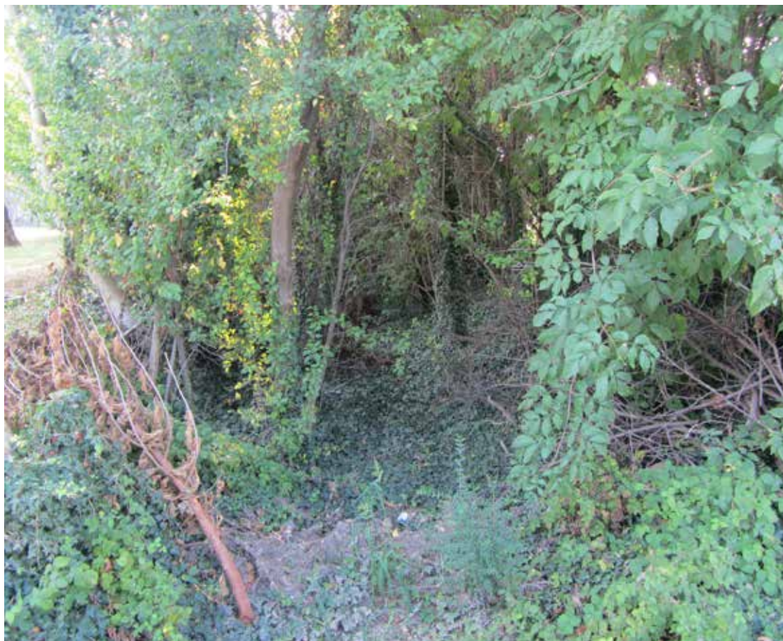
5. Il fossato della cortina oggi occupato da ramaglie e fitta vegetazione spontanea comprendente anche alberi ad alto fusto infestati da edera (da sud verso nord).
