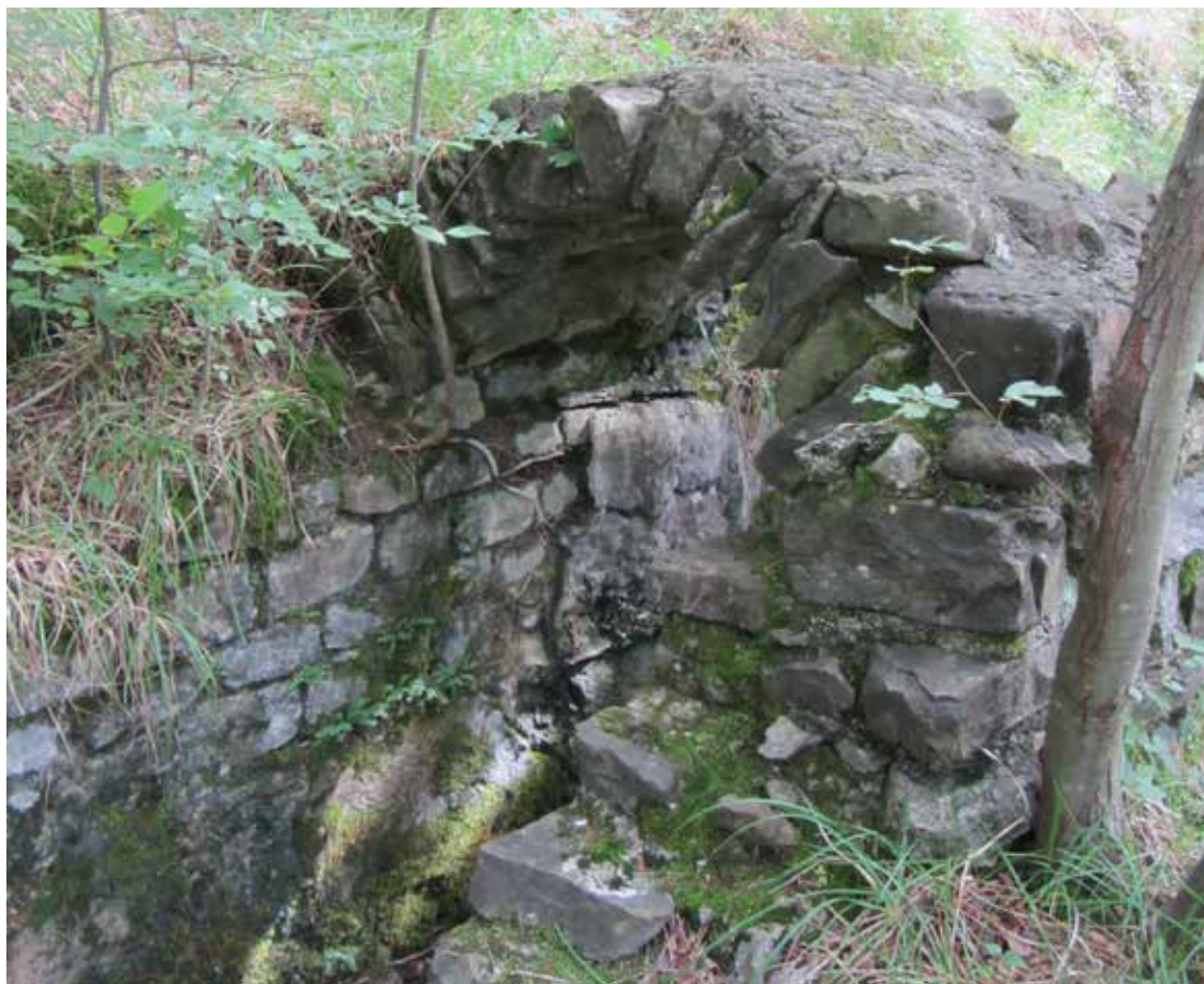
4. Particolare della volta dell'infrastruttura idrica.
