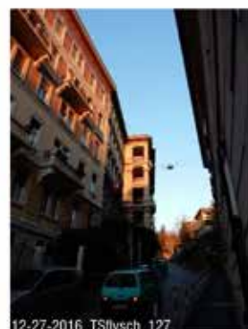
12-27-2016 TSIllysch 127 Via di Scorcola, edifici di pregio fine XIX sec.
