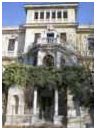
IMG_0856.JPG 24-03-2005/ Gianluca Paron/ Facciata Ovest
