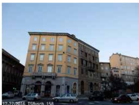
12-27-2016 TSIllysch 158 Scorcola, piazza Dalmazia, palazzo Fabris in primo piano.
