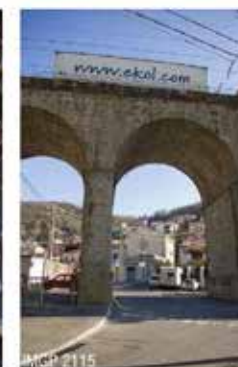
IMGP-2115 Sottopasso ferroviario.
