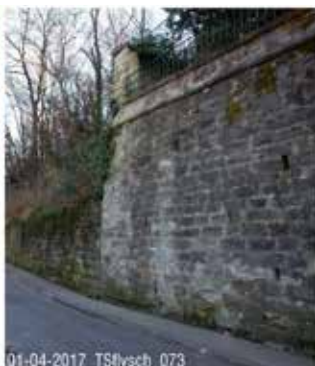
01-04-2017 TSflysch_073 Via Pindemonte, muro di contenimento in arenaria, limite Parco del Farneto-Cacciatore-Boschetto.
