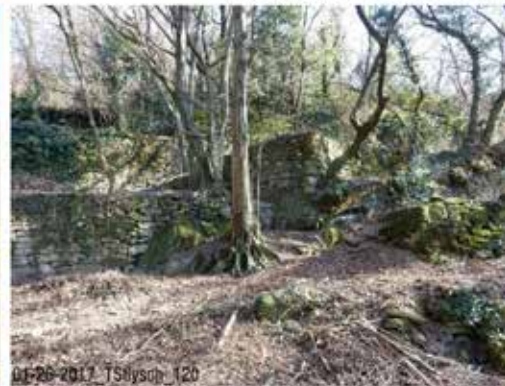
01-26-2017_TSIlysch_120 Sistemazione del versante a "pastini", in abbandono.
