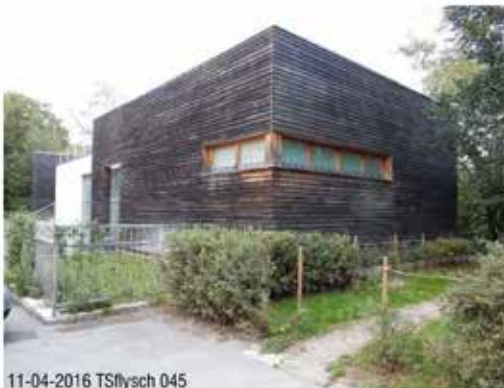
Nuova edificio del M.I.B..
