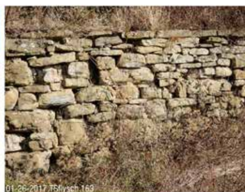
01-26-2017 TSlysch 169 Muro in pietra arenaria.
