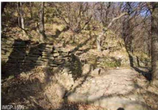
Parco, muri di contenimento in arenaria.
