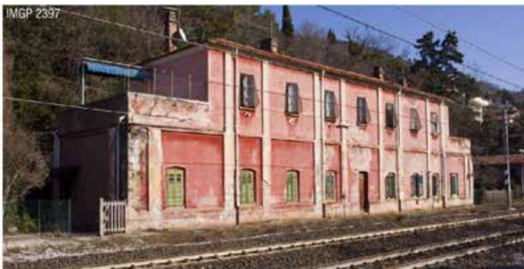
Edificio operai stazione di Grignano.
