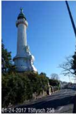
01-24-2017 TSIllysch 258 Il Faro della Vittoria, visto da S.da del Friuli.
