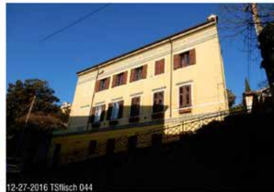
12-27-2016 TSflisch 044 Edificio su v.del Panorama.
