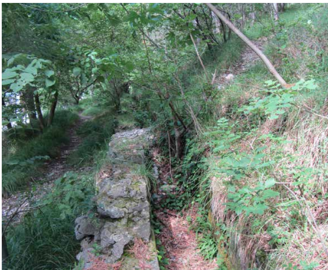
9. La struttura dell'acquedotto ricoperta da vegetazione spontanea.
