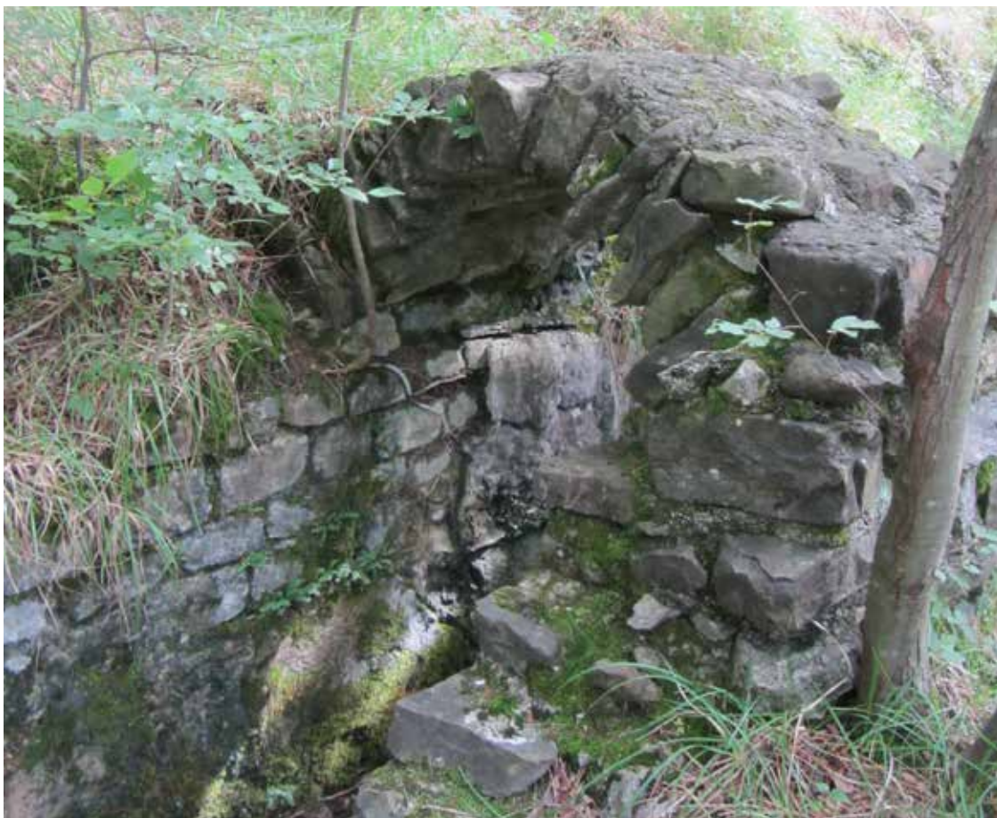
4. Particolare della volta dell'infrastruttura idrica.
