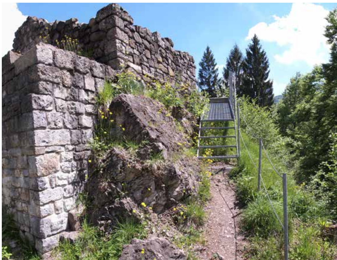
6. Particolari delle murature del castello di Sacuidic dopo la pulizia e il restauro
