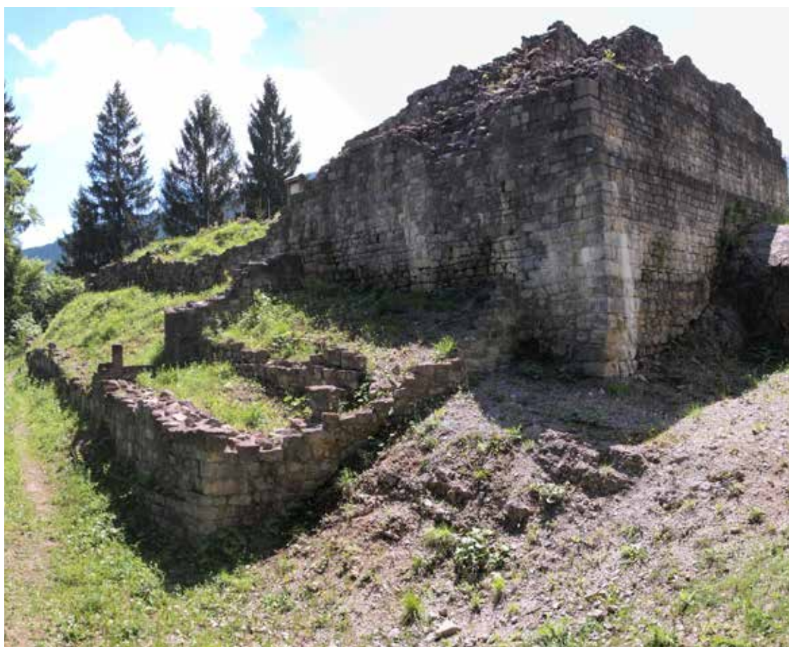
7. Particolari delle murature del castello di Sacuidic dopo la pulizia e il restauro
