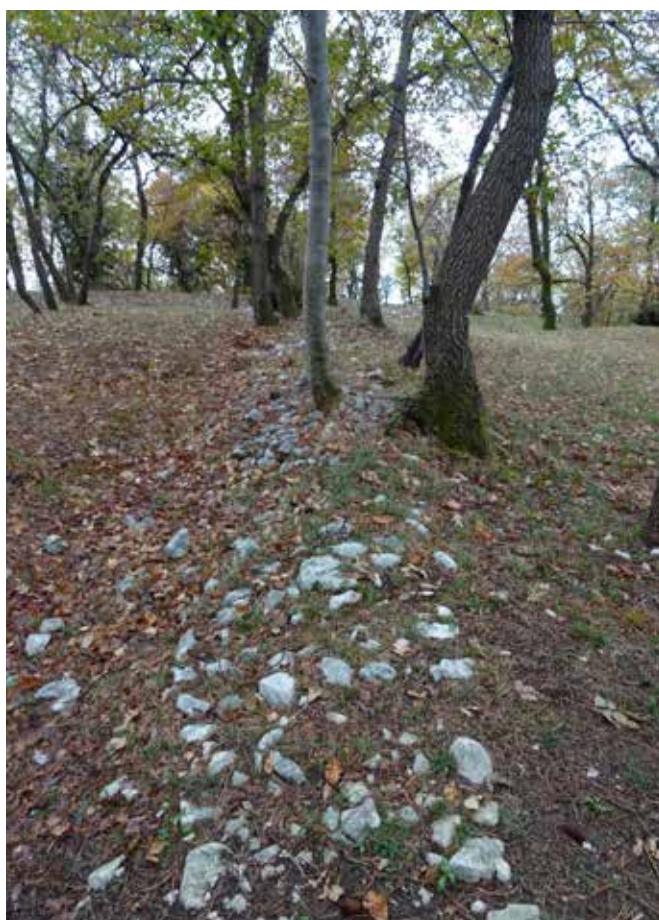
8 e 9. Muro ottocentesco a delimitazione delle particelle catastali
